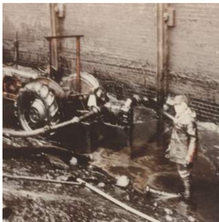
Pulizia depositi combustibile fossile con VL a Dublino
