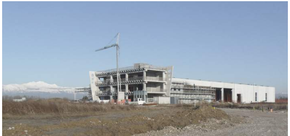
Il cantiere della sede pompe-decompressori in Z.I. Fiumesino
